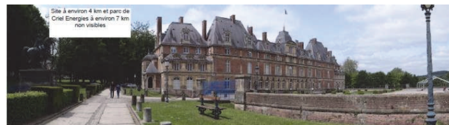
Figure 16 : Château de Eu. Vue vers le sud-ouest et l'ouest
