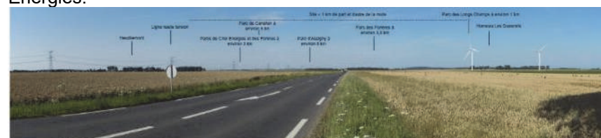
Figure 6 : Illustration du contexte éolien - vue vers l'ouest sur la RD925 à la sortie ouest d'Etalondes.
